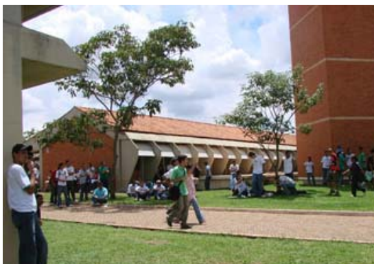
Fachada do Prédio de Meteorologia.
