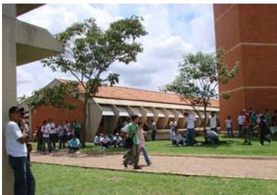
Imagen del Edificio de Meteorología.
